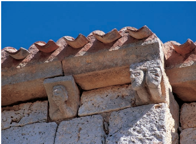
Canecillos del muro sur
