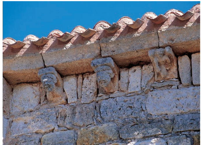
Canecillos del muro sur
