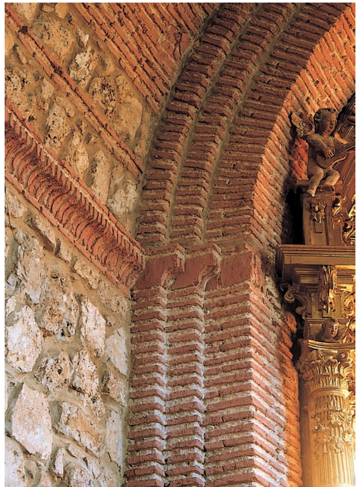
Detalle del interior de la capilla mayor
